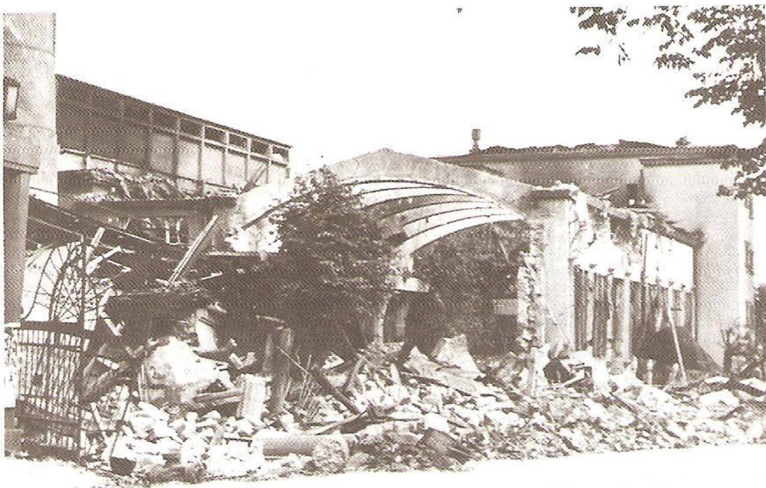
Purustatud masinamaja. Tagaplaanil (paremal) tervena säilinud jaotusseadmete hoone
