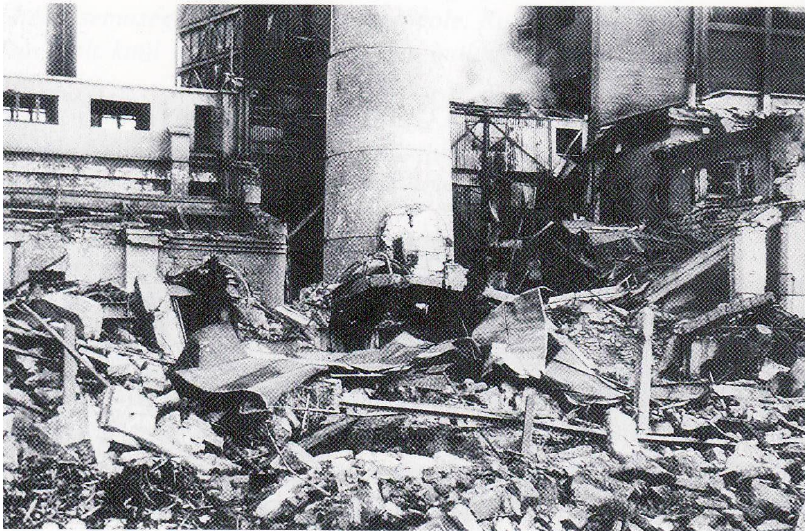
Purustatud masinamaja. Tagaplaanil purustatud katlamaja
