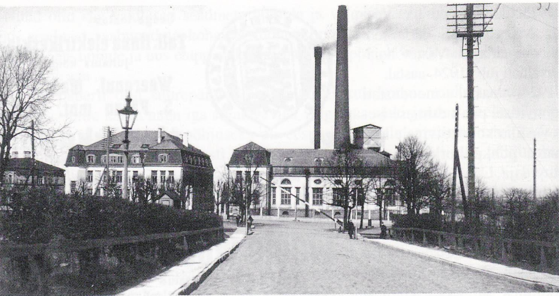
Tallinna Linna Elektri Keskjaam nägi aastail 1924–1929 välja nii – jaamal oli kaks korstnat 1925. aastast Tallinna Linna Elektri jaam
